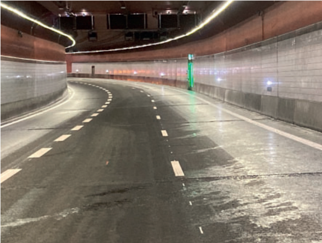
Mariefholmstunnel Göteborg Schweden
